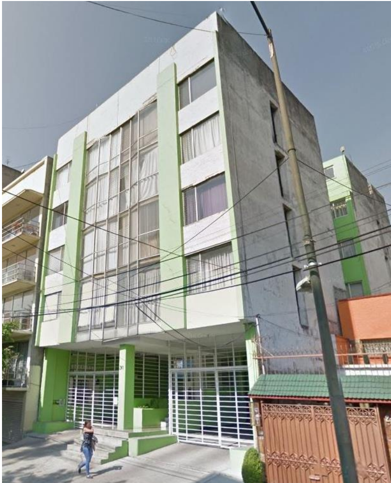
Antes del sismo
