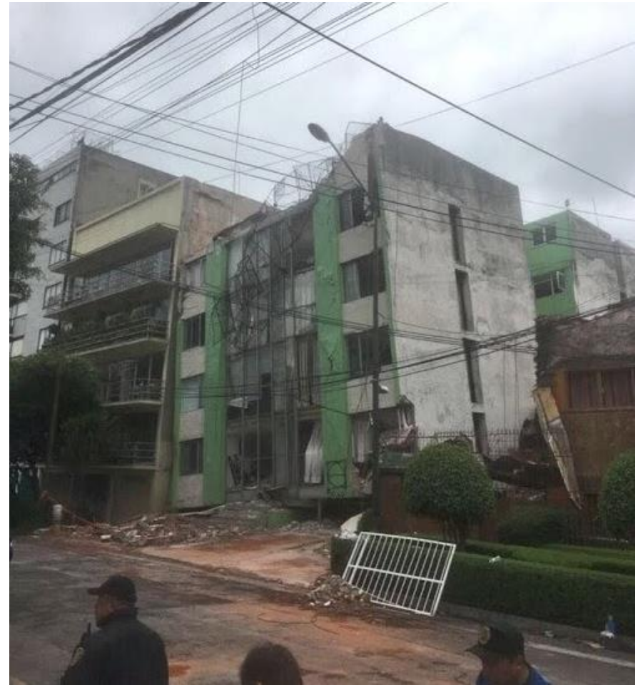
Después del sismo
