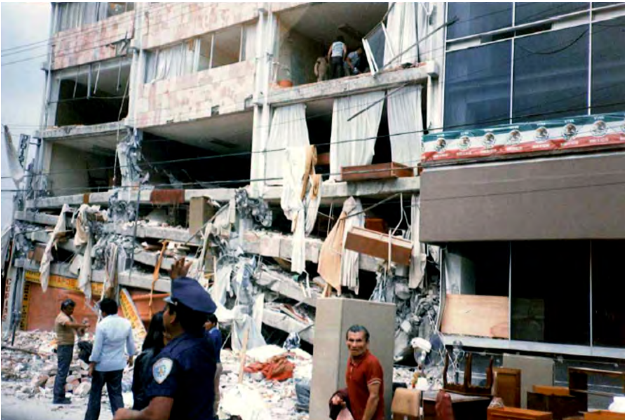
Edificio dañado por el sismo de 1985
