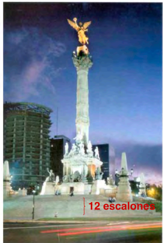
Hundimiento del Ángel de la Independencia, Reforma, Ciudad de México Fuente: Seminario de Terremotos (Cámara Dominicana de Aseguradoras y Reaseguradoras, Inc.), "Riesgos Catastróficos; Lecciones Aprendidas en el Mercado Mexicano", Recaredo Arias, marzo 2010
