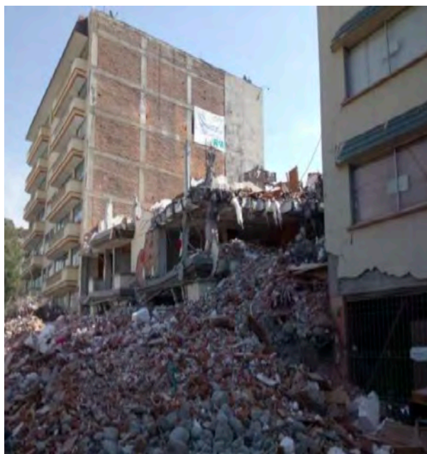
Condominio derrumbado por el sismo del 19 de septiembre, colonia Lindavista, Ciudad de México. Fuente: Fotos compartidas por grupos de trabajo de la AMIS
