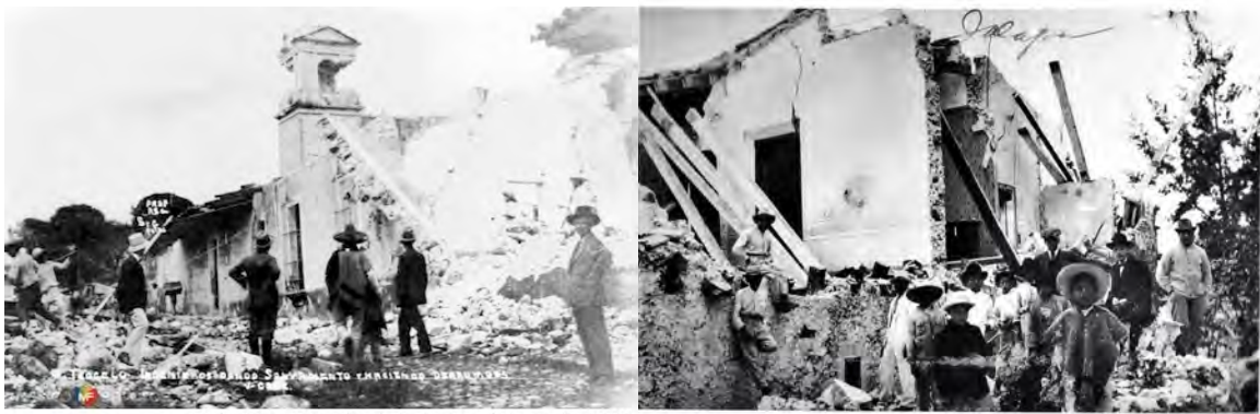
La iglesia de Teocelo, dañada por el sismo de 1920.
