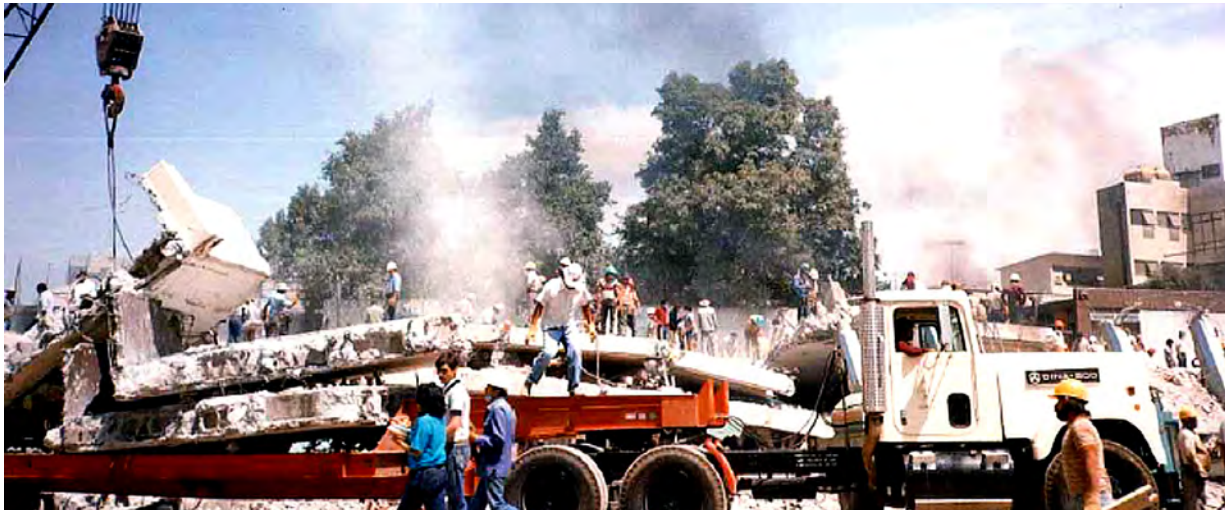
Trabajos de demolición y retiro de escombros de los edificios dañados. Fuente: Fotos compartidas por los miembros del comité y grupos de trabajo daños AMIS
