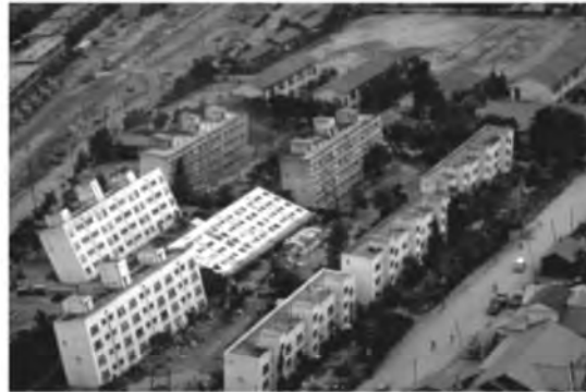
Figura 1.4 - Edificios inclinados por licuación de arenas
